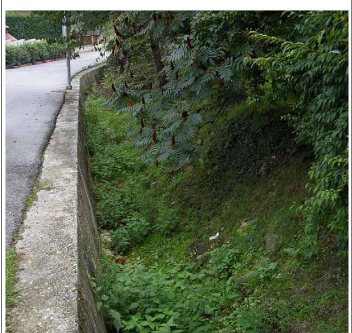
Foto 2 Sezione tipo del Rio S. Giovanni nel conoide tra il versante ed il fondovalle
