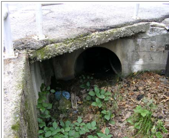
Foto 7 Tombatura di attraversamento della SP, di diametro 80 cm
